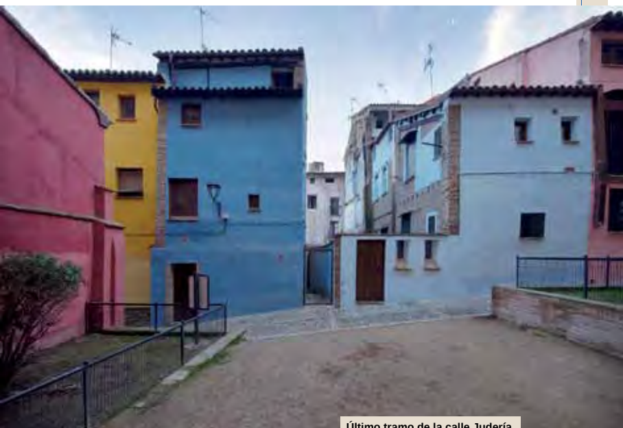
Último tramo de la calle Judería, con las fachadas restauradas.
