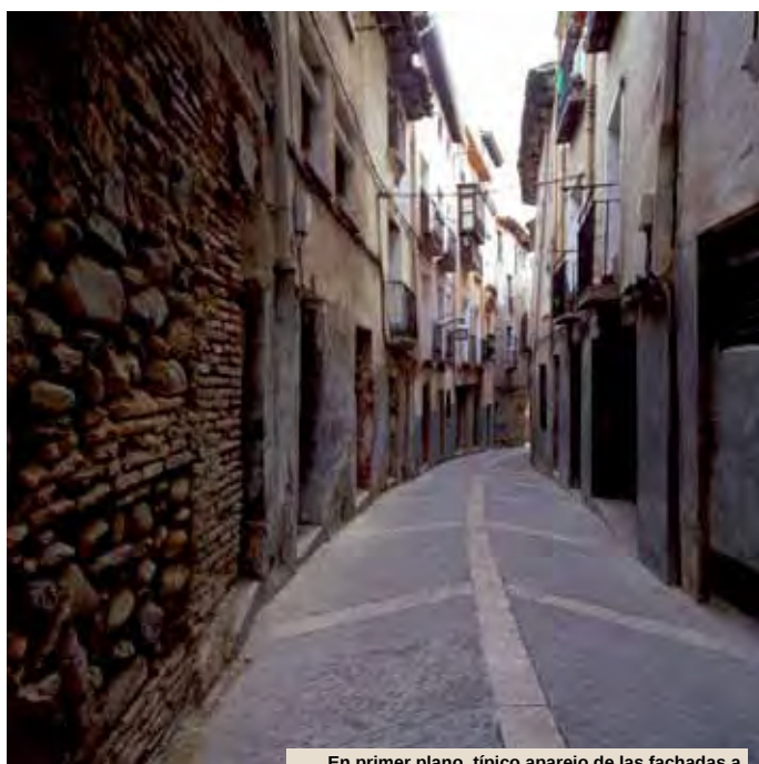
En primer plano, típico aparejo de las fachadas a base de mortero de cal con cantos rodados. Rúa Alta
