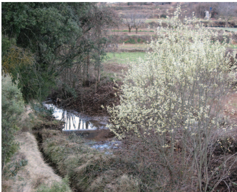
Azud y canal que suministraba el agua para el molino situado junto a la Virgen del Río. Foto: Ismael González y Marian Pulido.
