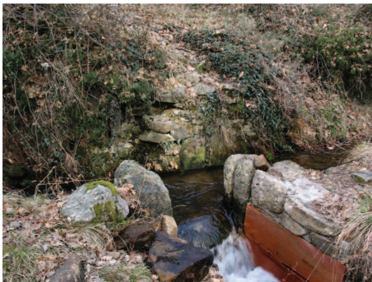
Piedras fitas junto a la almenara del Rincón de Layla. Foto: Javier Navarro.
